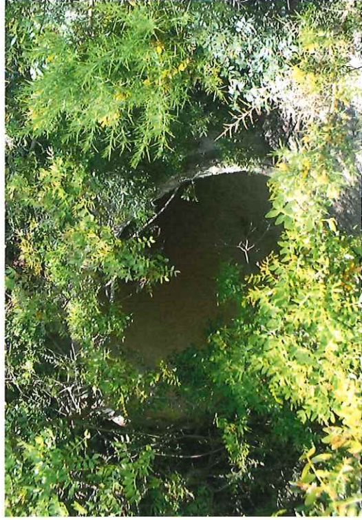
Foto núm. 5: Detall de l'obra de desguàs existent sota la N-340 (d = 1300 mm)
